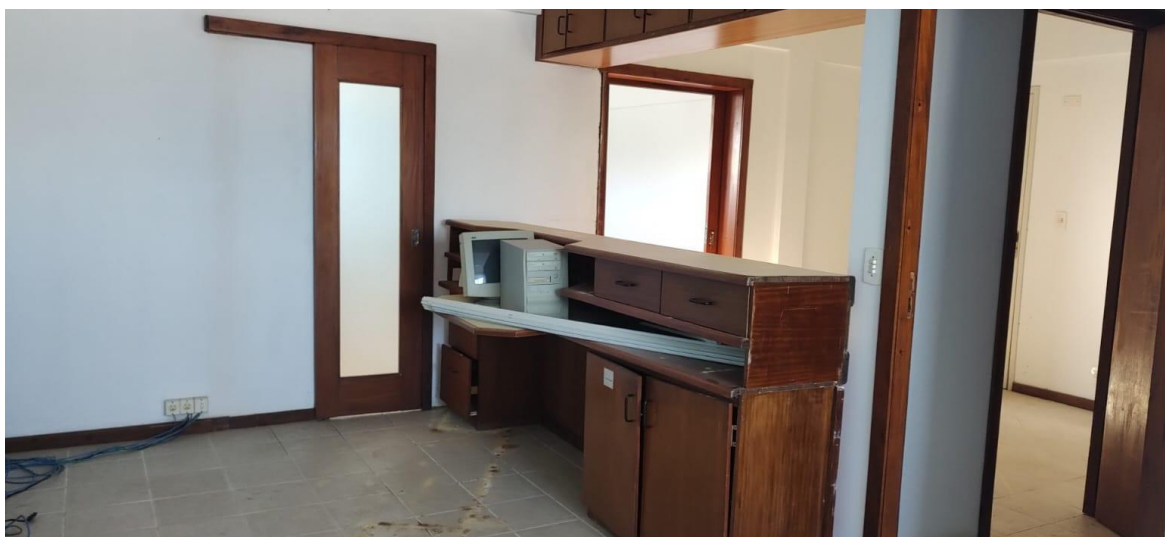
Foto 4: Sala interna Fonte: Carvalho Lira Engenharia, 2026
