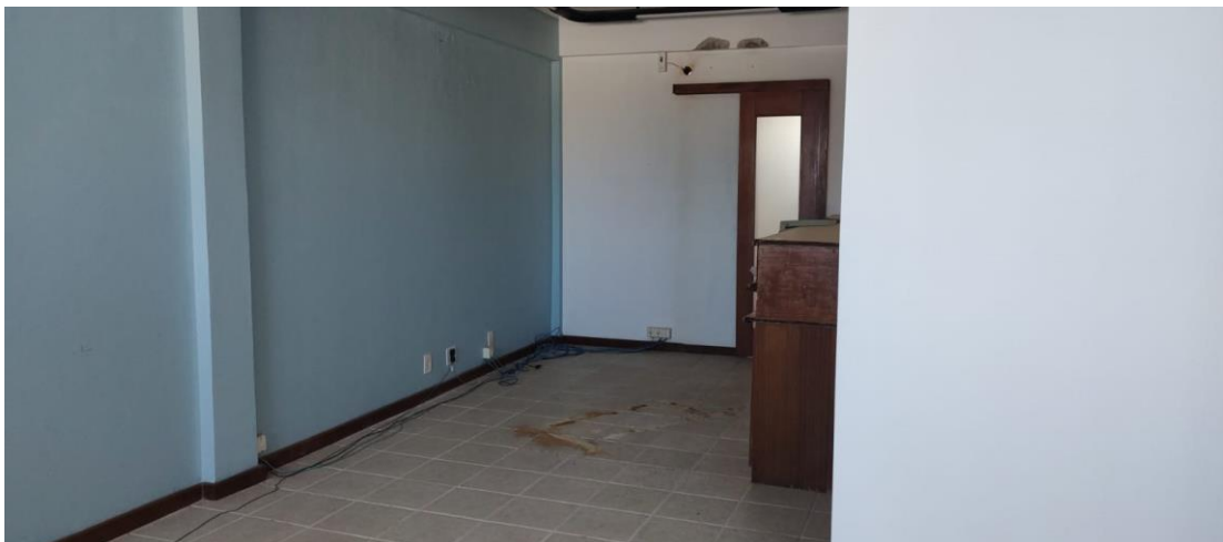
Foto 3: Sala interna Fonte: Carvalho Lira Engenharia, 2026
